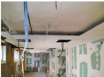
Baustelle im Klublokal
