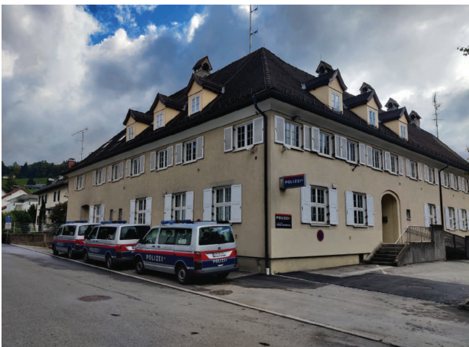
Aktuelle Dienststelle der Fremdenpolizeiinspektion in Vorarlberg, Dornbirn, St.-Martin-Straße 6
